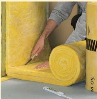
Den derart eingebauten 80 mm Filz nun auf Länge schneiden.
