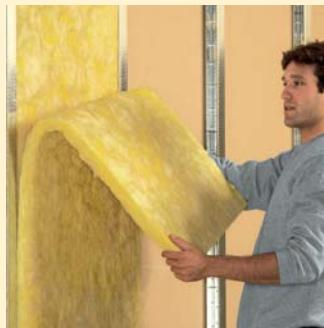
Durch kurzes „Anlüften“ (der Filz wird dabei an einer oberen Ecke gefasst) und anschließendem Abspalten der oberen 40 mm-Lage des 80 mm dicken TF Twin wird der Filz geteilt.
