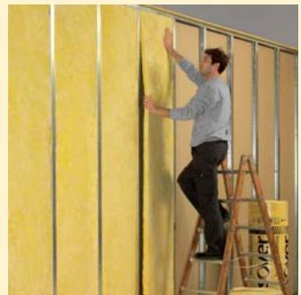
... durch Eindrücken fixiert. Der Breiten-Klemmzuschlag sichert den Filz gegen Abrutschen.
