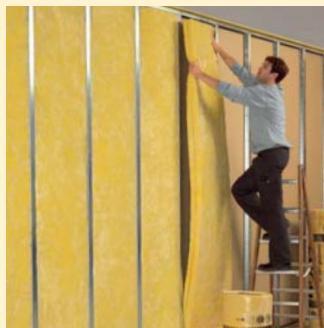
Den 80 mm-Filz greifen, ungeteilt im Gefach hochziehen und in das Gefach einbauen.
