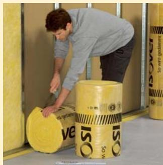
Eine Einzelrolle vor das Gefach legen; die zweite davor stellen. Anschließend die Verpackung der liegenden Rolle aufschneiden. Die stehende Rolle sichert die liegende gegen das Aufrollen.
