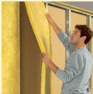
Ohne die Leiter zu verlassen wird die obere, abgespaltene 40 mm-Filzlage ins Nachbar-Gefach eingepasst und ...
