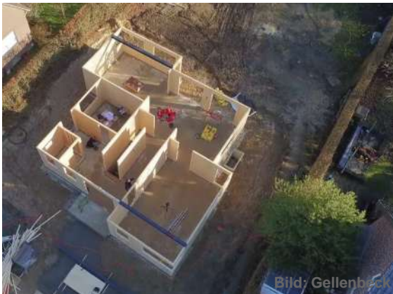
Abb. 7 Bautenstand am Morgen, die EG-Wände sind montiert.
