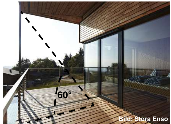
Abb. 20 Das Dach dieses Balkons bildet die nach außen durchlaufende Brettsperrholzdecke. Eine Dachuntersicht ist aufgrund der geschützten Lage der Nutzungs-kategorie NKL 2 zuzuordnen.
