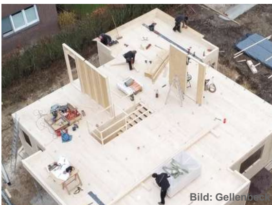
Abb. 8 Bautenstand am Nachmittag. Die Decke ist verlegt und die Montage des Obergeschosses beginnt.
