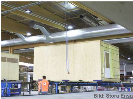
Abb. 19 Raummodule aus Brettsperrholz werden in einer Werkhalle montiert und ausgestattet.
