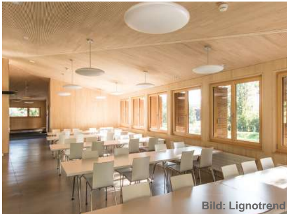
Abb. 21 Räume mit glatten Oberflächen an Wänden und Böden können an den Decken akustisch optimiert werden.
