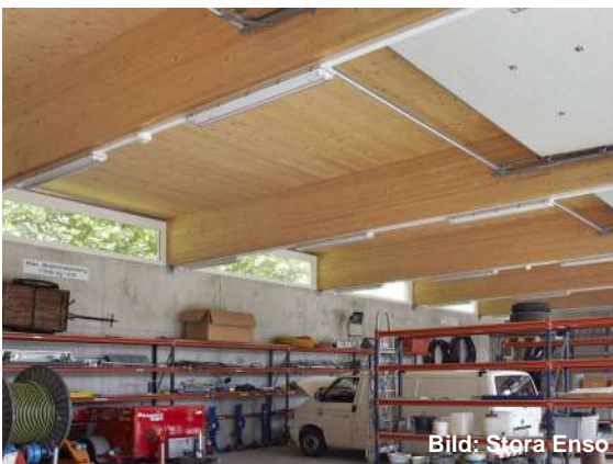
Abb. 25 Unbeheizte Hallen und Gewerberäume: die Brettsperreholzelemente bringen bereits eine Grunddämmung für ein angenehmeres Klima sowohl im Winter wie im Sommer.
