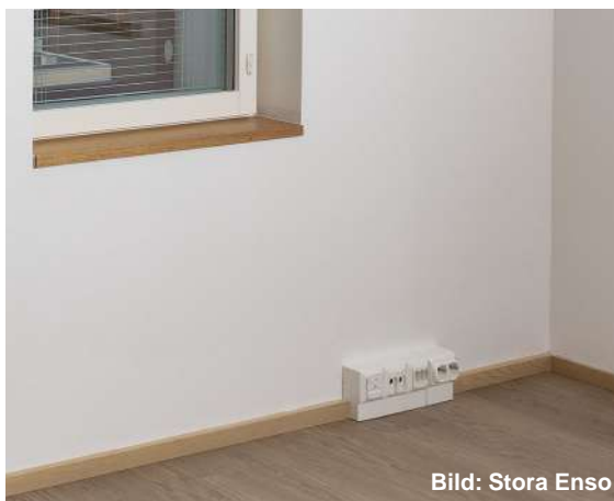
Abb. 62 Elektroinstallation mit Hilfe der Fußleisten hat seine Vorzüge. Alles ist leicht veränderbar.
