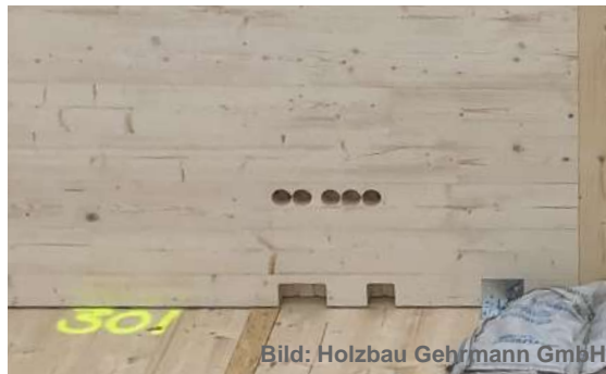
Abb. 61 Bereits im Abbund (Zuschnitt im Herstellwerk) wurden die Aussparungen für die Elektroinstallationen vorbereitet. Die Aussparungen werden durch Estrich und Fußleiste abgedeckt.
