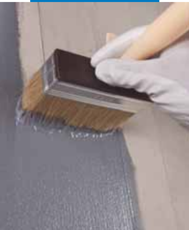
Aufstreichen von Eco Prim Grip auf Beton
