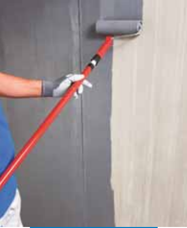
Aufrollen von Eco Prim Grip auf Beton
