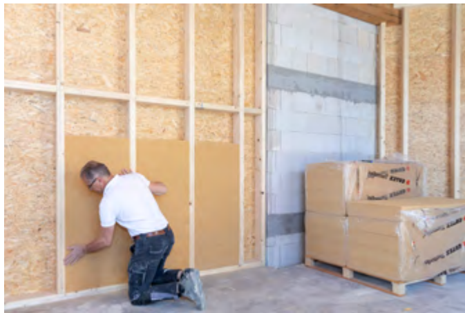
Außenwanddämmung mit Vorsatzschale
