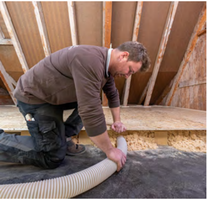
Begehbare Geschossdecke mit Holzfaserdämmung
