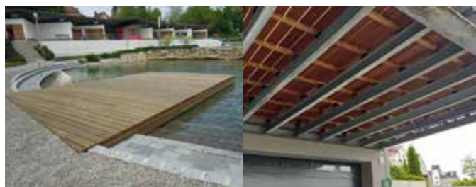
Stege über Wasser
