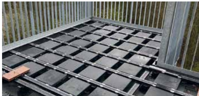
Die Betonplatten können je nach erforderlichen Bemessungswerten für die Windlast eingelegt werden.
