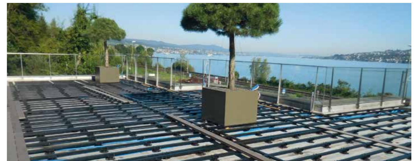
Aluminiumunterkonstruktion mit Stelzlagern und Verstellfüßen.
