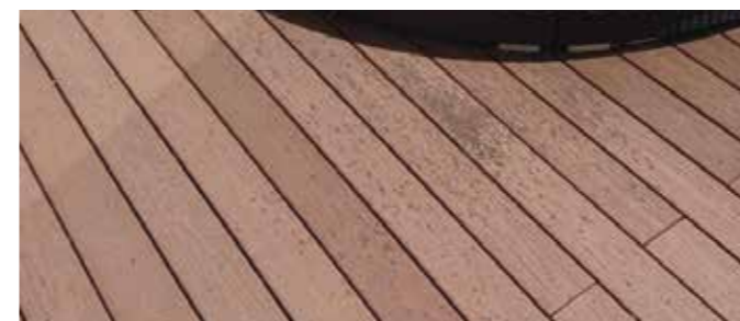
Fleckenbildung durch Sonnencreme bzw. Sonnenöl am Einstieg beim Whirlpool.
