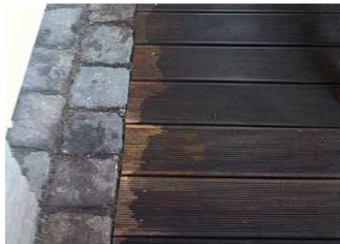
Ausgelaufenes Paraffin kann nur schlecht entfernt werden und führt häufig zu Reklamationen.
