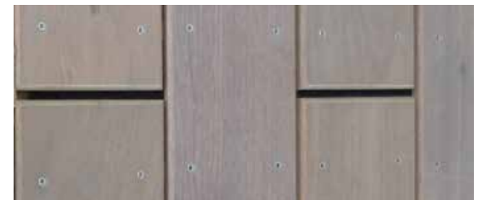
Auf jeder Unterkonstruktion müssen immer 2 Verschraubungen erfolgen.
