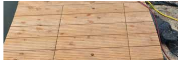
Bei Revisionsklappen aus Holz muss der bauliche Holzschutz beachtet werden.
