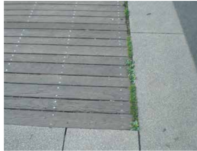
Fugen sollten von Laub, Dreck und Unkraut befreit und dauerhaft sauber gehalten werden.
