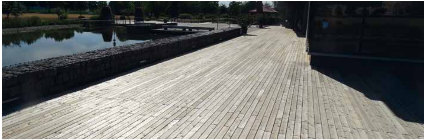
Umwelteinflüsse führen bei Holzterrassen zu einer Vergrauung.
