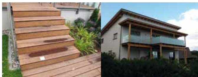
Treppe > 60 cm Höhe
