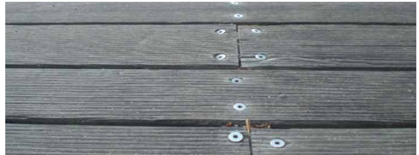
So sollte ein Schraubbild nicht aussehen. Die Schrauben sind nicht in einer Flucht geschraubt.
