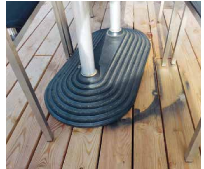
Verfärbung durch Tischuntergestell aus Metall bei Lärche.
