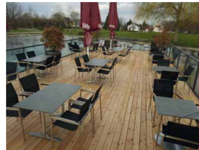
Bei Terrassen, die bei Hotel- oder Gastronomieobjekten geplant werden, muss mit höheren Punktlasten durch das Mobiliar gerechnet werden. Bei genutzten Profilen können evtl. die Kanten durch die Belastung abbrechen.
