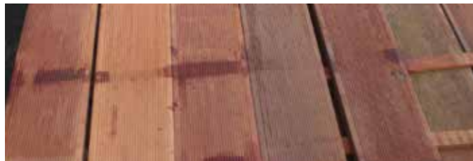
Das Abzeichnen der Durchleger wird erst bei der Kommissionierung der Ware sichtbar.
