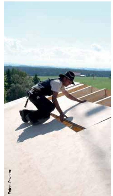
Abb. 6 Folien dämmen nicht. Einer vollflächigen Holzfasерplatte mit Nut und Feder sieht man die Dämmleistung bereits an – ein Multifunktions-talent.
