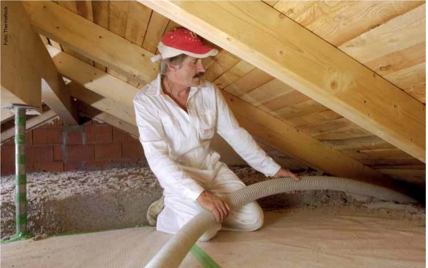
Abb. 9 Viele Hohlräume lassen sich im Altbau mit Einblasdämmstoffen effizient nutzen – aber das richtige Material muss es sein.
